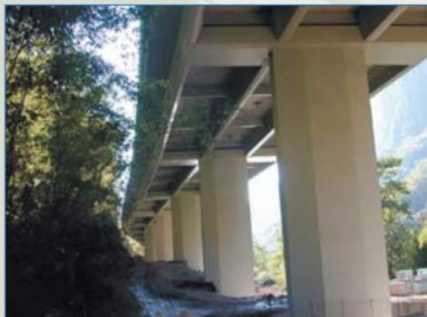
**Rasatura Generalizzata (3-5 mm) con malta cementizia additivata con polimeri e rinforzata con fibre in poliacrilonitrile. Ravvivatura dell'intera superficie e rivestimento con resine metacrilliche.**
