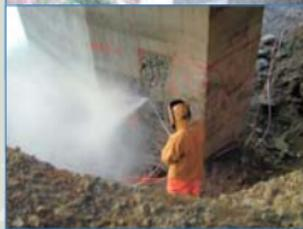
**Idrodemolizione delle porzioni di calcestruzzo "laminato", fessurato o comunque degradato, rinvivatura con getti ad alta pressione di sabbia silicea di tutte le superfici rimanenti.**
