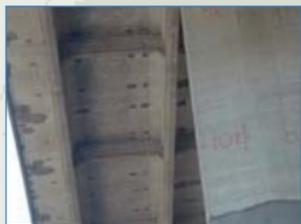
**Applicazione nelle zone oggetto dell'idrodemolizione, di malta cementizia additivata con polimeri e rinforzata con fibre in poliacrilonitrile.**
